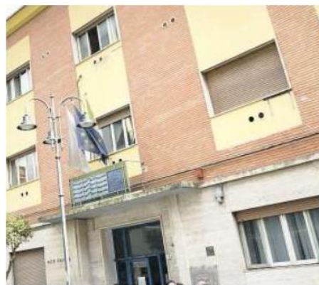
LA STRUTTURA La sede dell'Alto Calore in corso Europa
