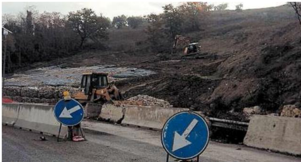
L'intervento Mezzi al lavoro per collocare e fissare il telo di protezione sul fronte di frana
