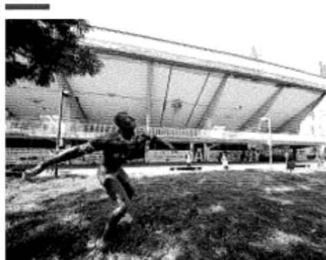
Collana. Con la gestione affidata alla società Giano, lo stadio dice definitivamente addio alle Universiadi si allungano anche i tempi di riapertura dell'impianto
