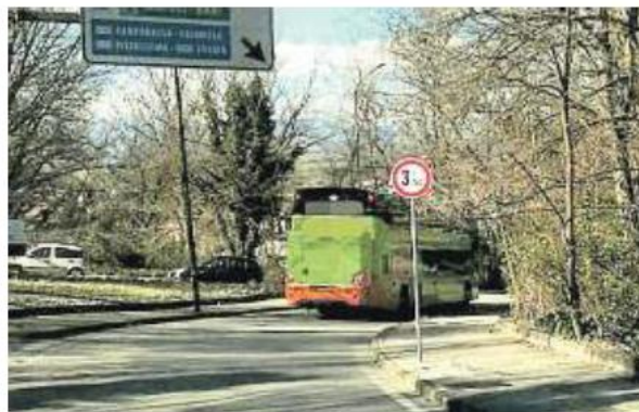
IL NODO Un pullman di passaggio sul ponte San Nicola
