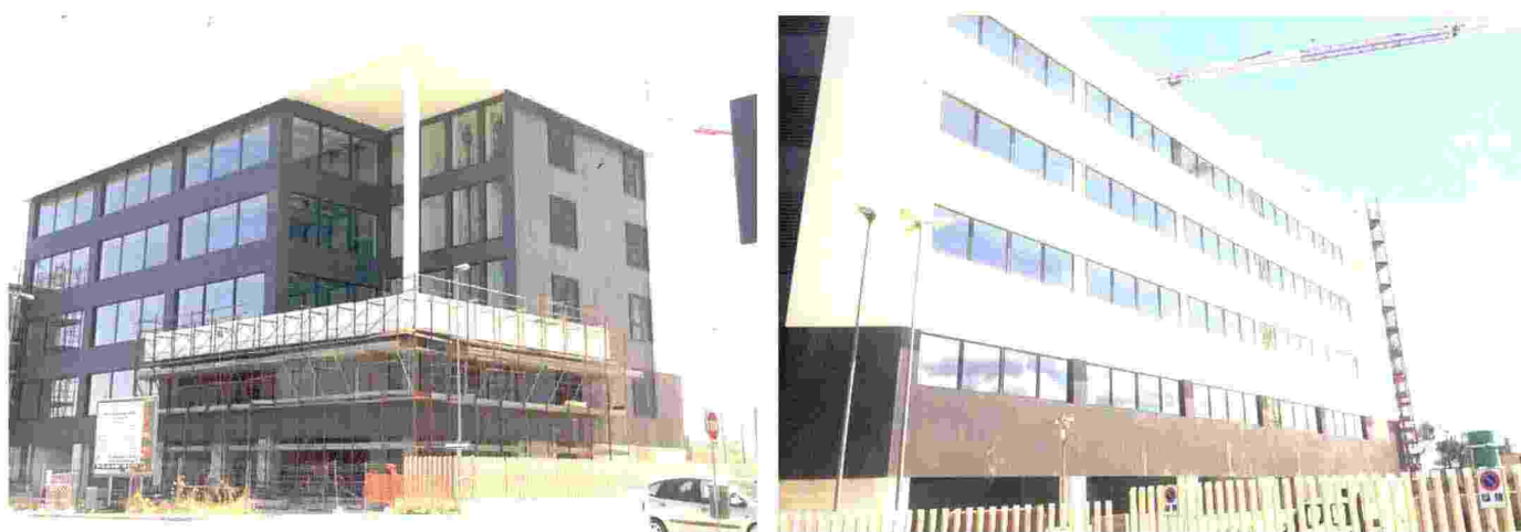
Il cantiere. Due immagini del nuovo building, da 22 milioni, che Fincons sta costruendo nei pressi dell'aeroporto di Bari
