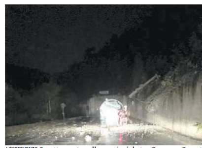
L'INTERVENTO Smottamento sulla provinciale tra Cusano e Cerreto
