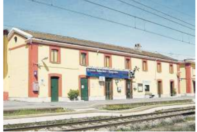
LA TRATTA L'attuale stazione di Frasso Telesino
